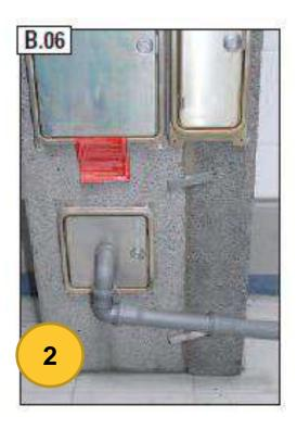
Einsatz des Kondensat-Beutels bei fehlender Einleitungsmöglichkeit
